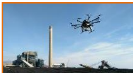
Thermal Power Plant (ALMERÍA)
